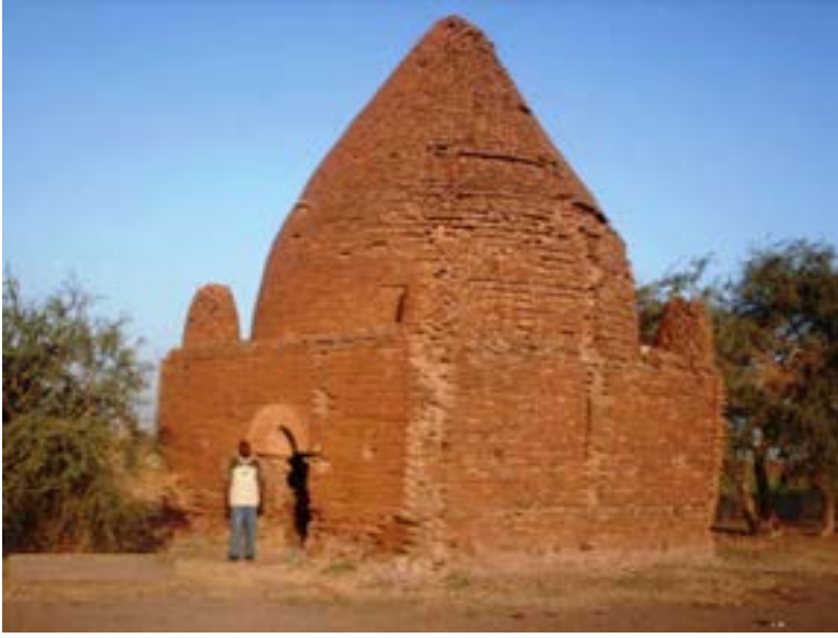
لوحة: 2. قبة الفقيه رحمة الحلاوي بقريّة شرفت الحلاوين بطرازها القديم (تصوير الباحث).
