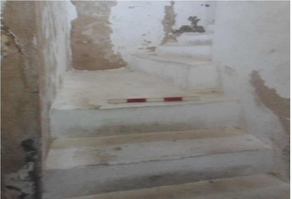
صورة رقم (35) توضح شكل سلالم البيت
