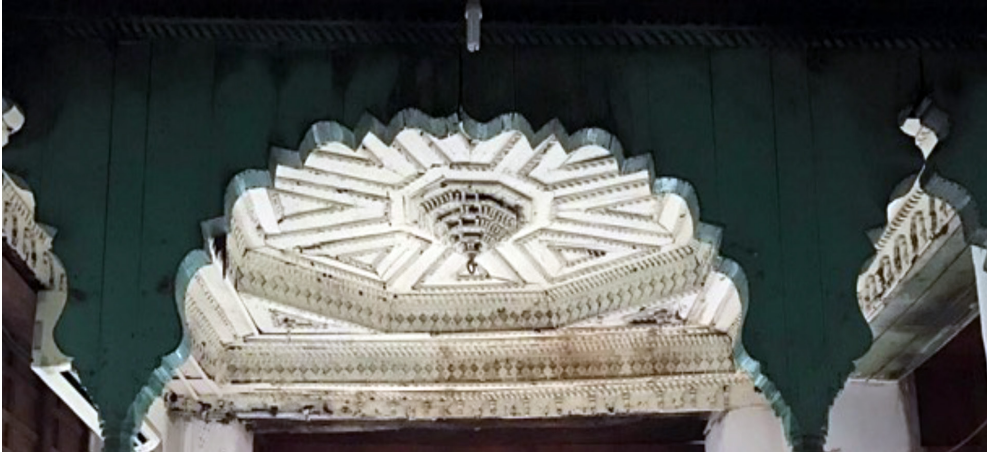
صورة توضح سقف الدكة
