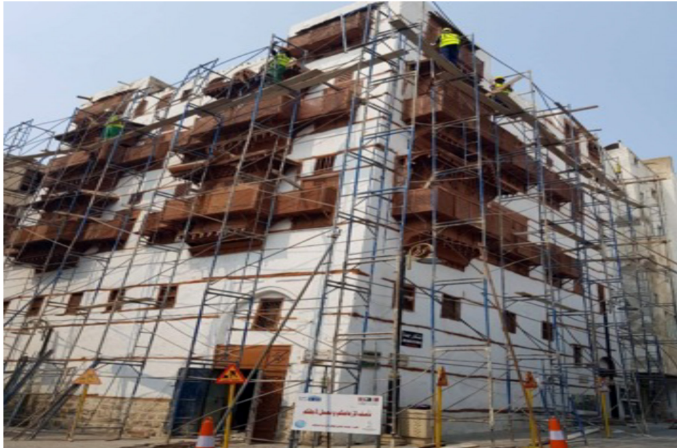
صور توضح أعمال الترميم في بيت المتبولي
