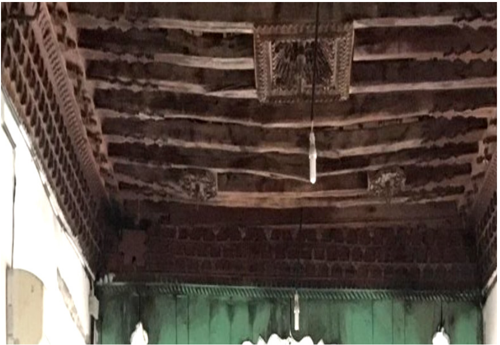
صور توضح أسقف البيت
