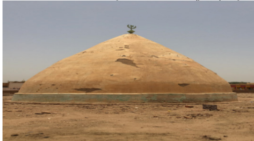
لوحة رقم (6) توضح انفصال طبقات الملاط على موقع قبة عبد القادر المنصور الكلاكلة)
